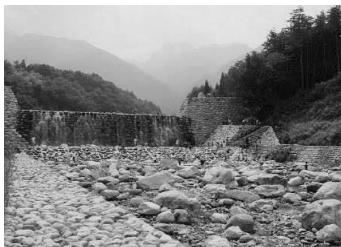
尾白川下流砂防堰堤
