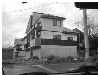
2004年 新潟県中越地震 ◎長岡市（旧川口町） | 貝の沢
