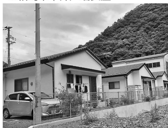
2018年 西日本豪雨災害 ◎大洲市 | 下鹿野川
