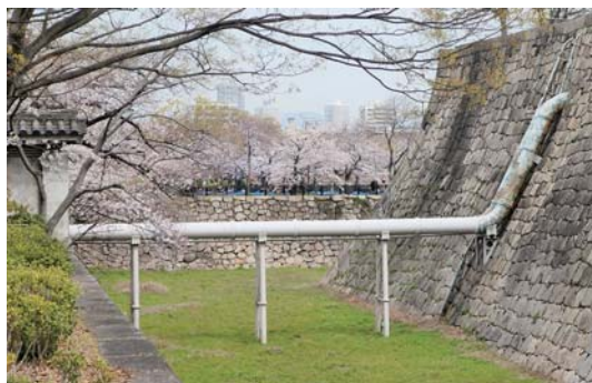
図4 空堀に設置された排水管
