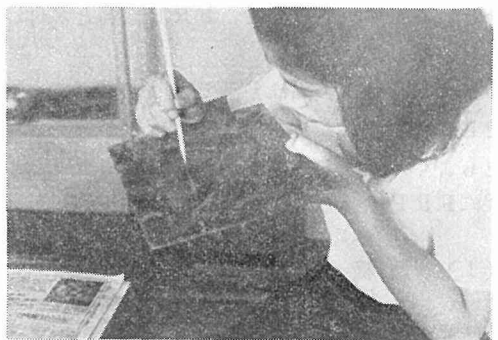
写真11 気泡の補修仕上げ
