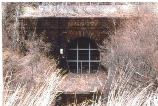
旧深沢トンネル：旧中央本線トンネル 明治36年竣工 甲州市
