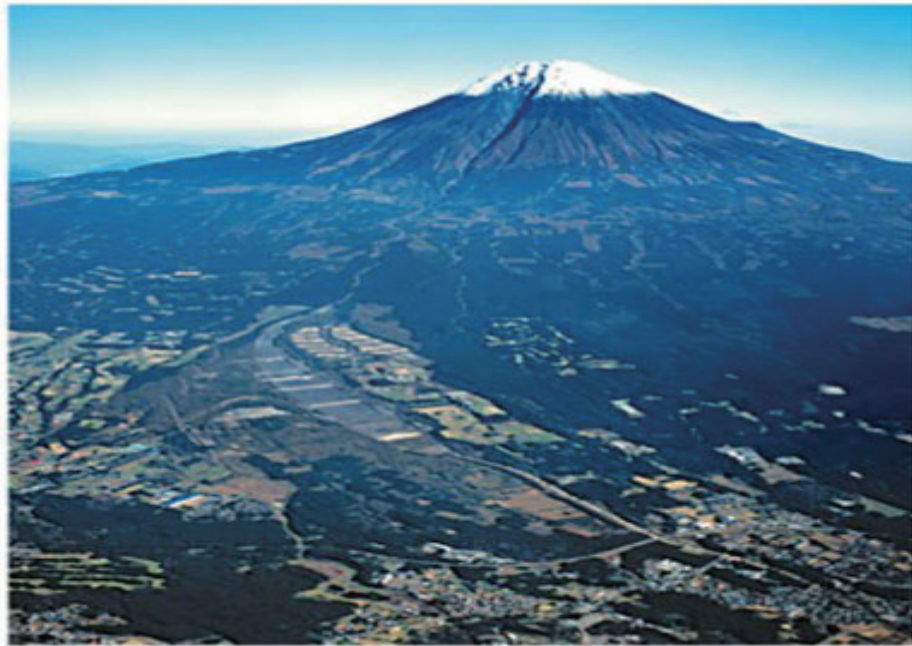
大沢遊砂地の砂防施設 (写真／国土交通省富士砂防事務所)
