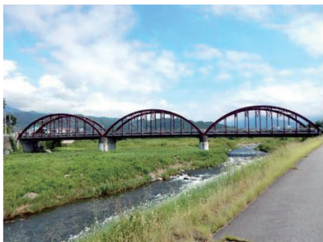
亀甲橋：三連アーチ下路式鋼橋 昭和8年竣工 笛吹市
