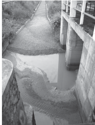
写真6 沈砂池から排出されない土砂（筆者撮影2010年12月30日）
