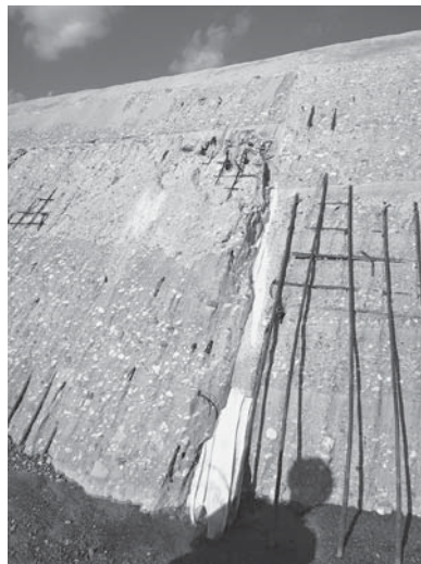
写真25 2016年7月の豪雨で損傷した堰の表面(撮影：古殿晴吾氏2016年9月7日)
