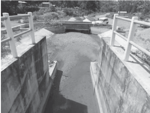
写真23 カラウルンスキーム。第二次改修後も続く土砂堆積。右手に掘り上げられた土砂の山。(筆者撮影2017年1月6日)
