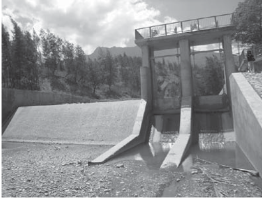
写真9 マリアナ第一灌漑スキーム：プロボ川中流に設けられた堰と排砂ゲート（下流側から筆者撮影2011年9月5日）
