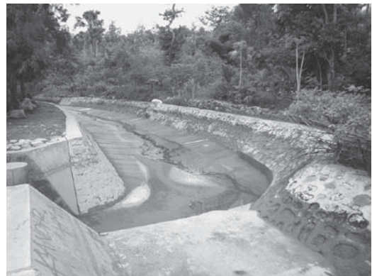
写真12 幹線水路の途中に設置された沈砂池。左手が排砂ゲート。手前が幹線水路下流。（筆者撮影2013年1月5日）
