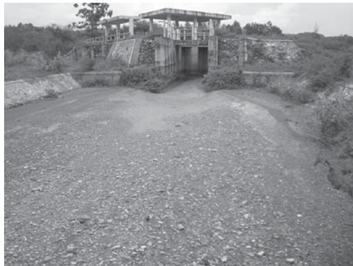
写真7 幹線水路の入り口で堆積する土砂（筆者撮影2010年12月30日）
