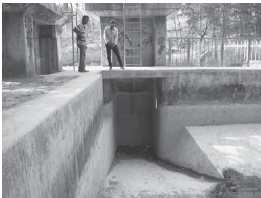
写真11 インテイクゲート裏の沈砂地に設置された排砂ゲート。ゲートの先は川。（筆者撮影2014年9月1日）
