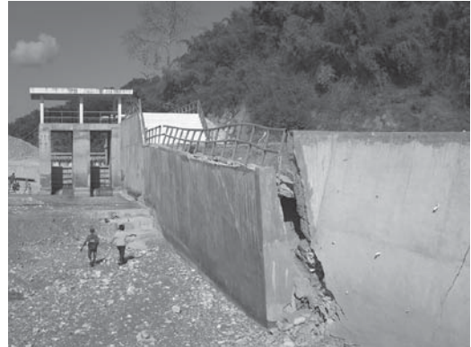
写真24 2016年7月の豪雨で決壊した護岸壁。水抜きパイプが埋め込まれていなかった。(撮影：古殿晴吾氏2016年9月7日)
