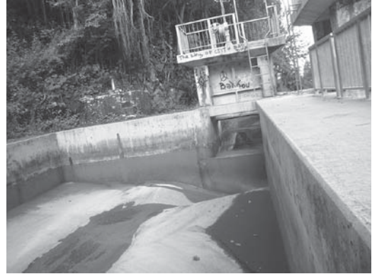
写真10 インテイクゲート裏の沈砂池。正面が幹線水路。右手に排砂ゲート。（筆者撮影2013年1月5日）
