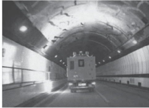
図17. 計測状況写真（トンネル内空の状態観測，資料集 [2] 424ページより）
