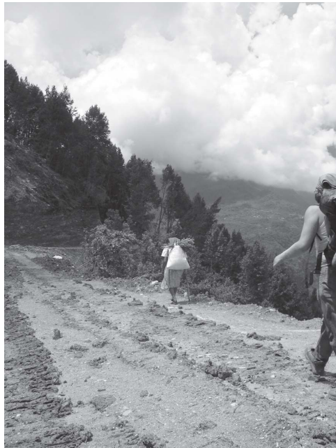
(写真1) 工事中の道路 2009年9月長谷川撮影
