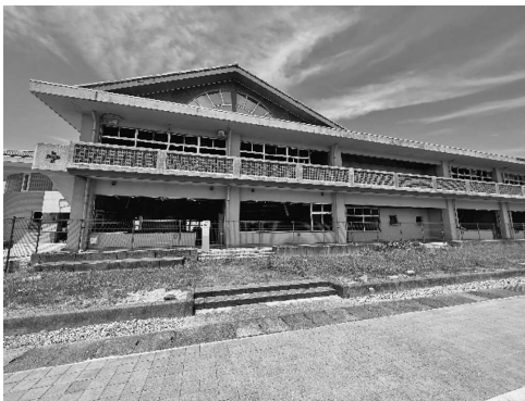
写真 2-4 中浜小学校の外観 2022 年 7 月 筆者撮影
