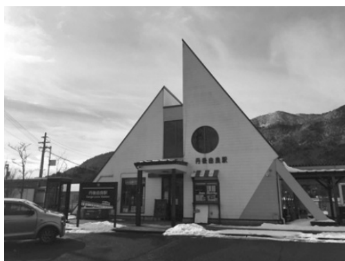
写真3-12 丹後由良駅の外観 2022年1月15日撮影：吉川昌志
