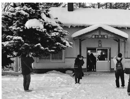
図表 3-10 新十津川駅舎の外観 2019 年 12 月 29 日筆者撮影
