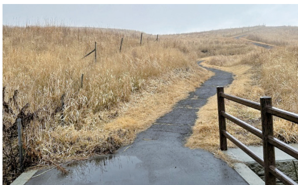
図14 公衆トイレから北側に分岐する散策路
